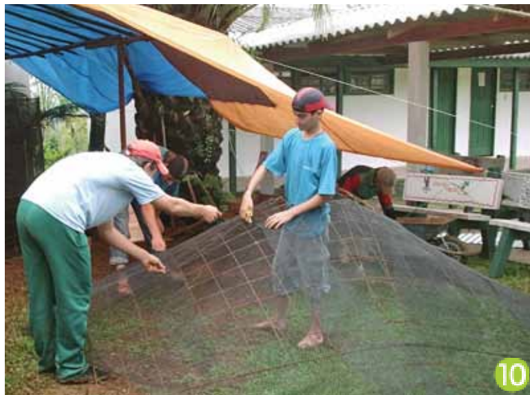
Amarração das partes da malha de ferro da tampa
