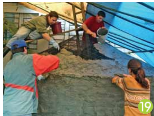
Momento do preenchimento da estrutura com massa.
