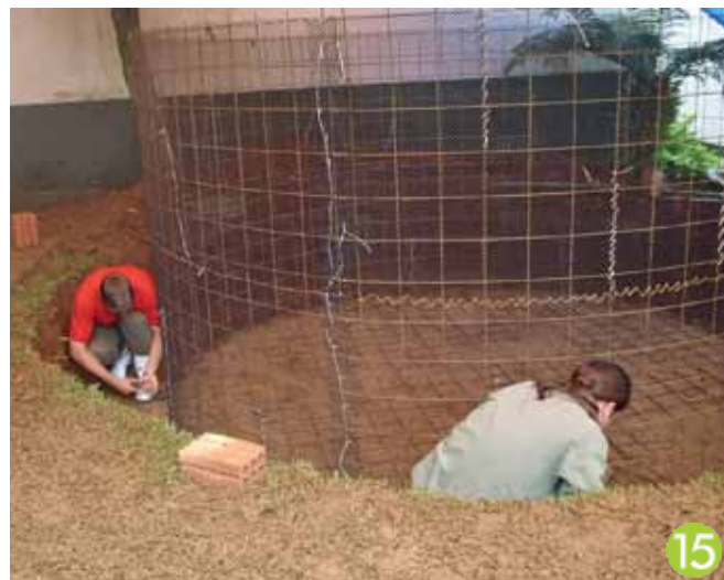
Amarração da malha de ferro e da tela nas paredes
