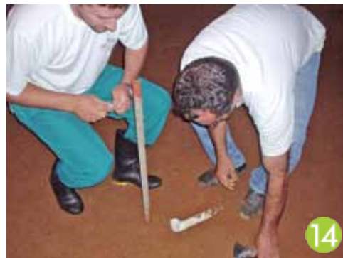
Fixação do cano de drenagem da cisterna
