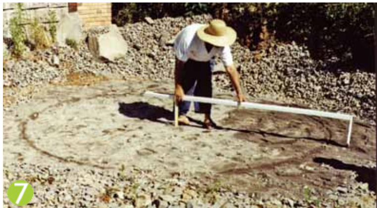
Preparação do terreno. Demarcação da circunferência.
