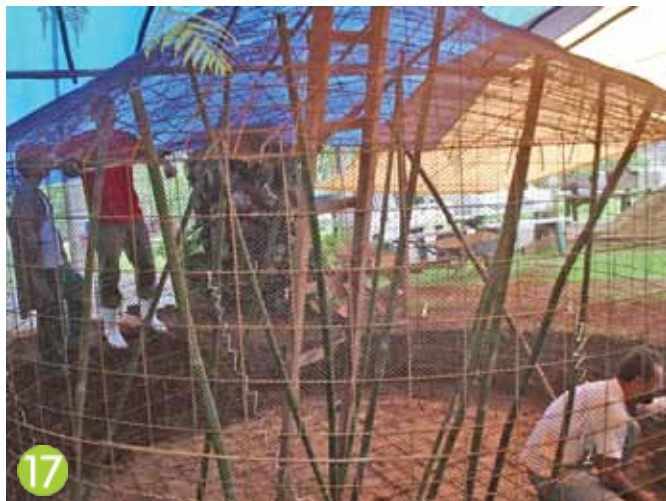
Estrutura de ferro montada com a tampa já posicionada
